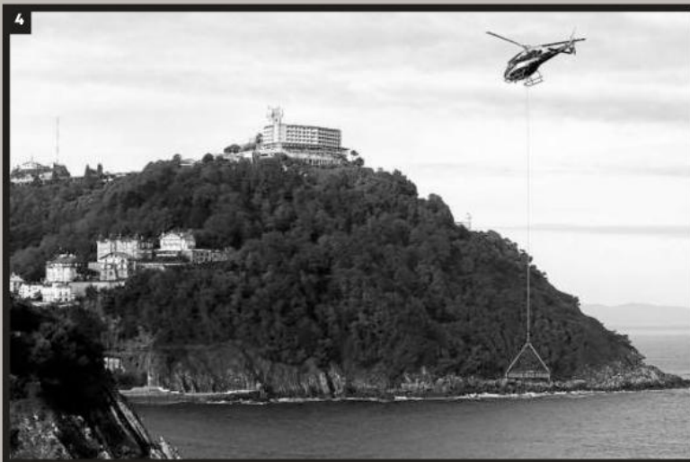
4. Una de las piezas de la base de la grúa en su trayecto por encima de la bahía.
