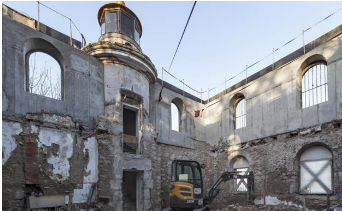
La casa del faro permanece sin cubierta hasta que se instale la nueva, a mediados de agosto. / IDOIA UNZURRUNZAGA
