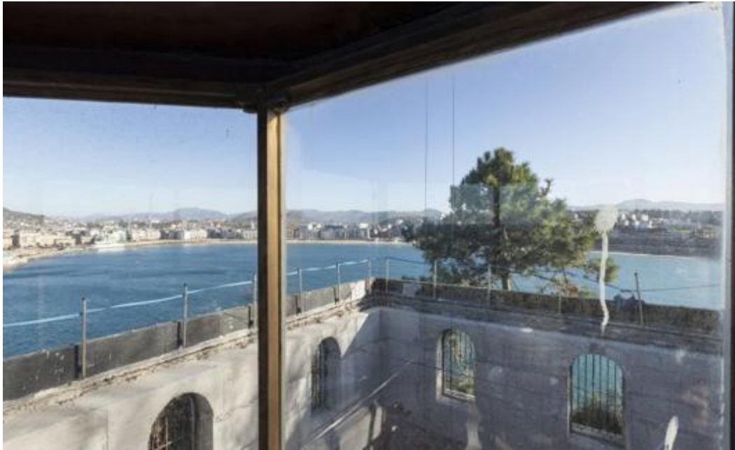
Vista de la bahía de La Concha desde lo alto del edificio en obras en Santa Clara. / i. U.
