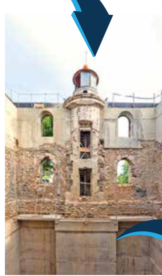
La casa del faro, en desuso desde 1968, fue restaurada y rescatada del olvido.
